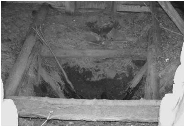
Рис. 13. Яма для льда внутри колхозного ледника. По своему устройству ледник в соседней д. Воробыи аналогичен леднику Елизаровых в Потаневщине
