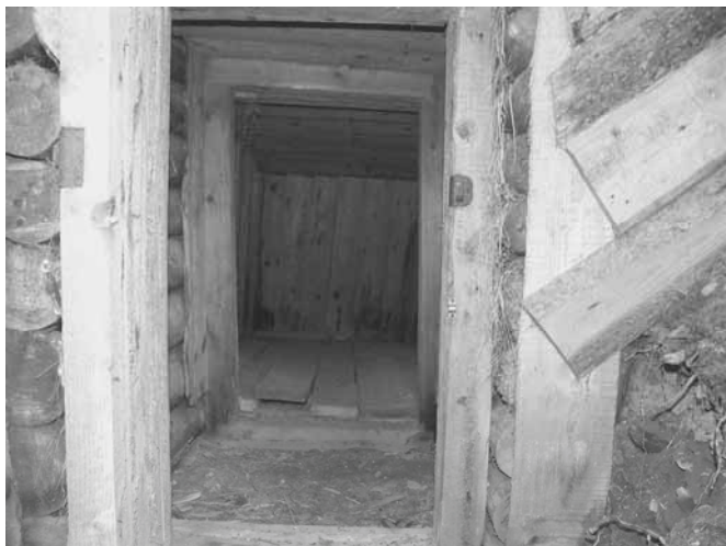
Рис. 15. «Тепловой тамбур» ямы, в который между двумя люками забивается утеплитель (сено)
